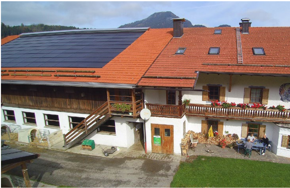
Die Indach-Solaranlage mit Warmluftabsaugung am Dachfirst
